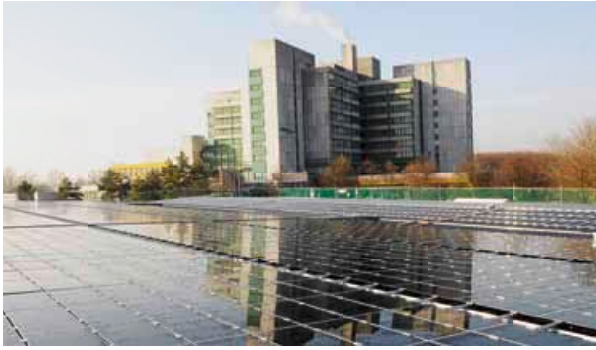
Mit Sonne Strom erzeugen: Auf dem Dach des neuen Parkhauses am Klinikum Worms wandeln Solarzellen die Kraft der Sonne in Energie um.
